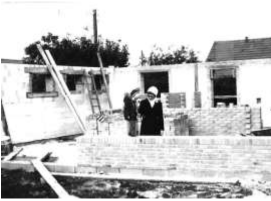
26.9.1971: Murerarbejdet er godt i gang
